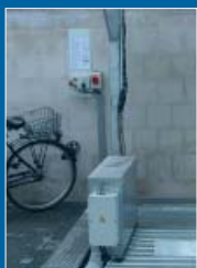
Abschließbarer Hauptschalter
