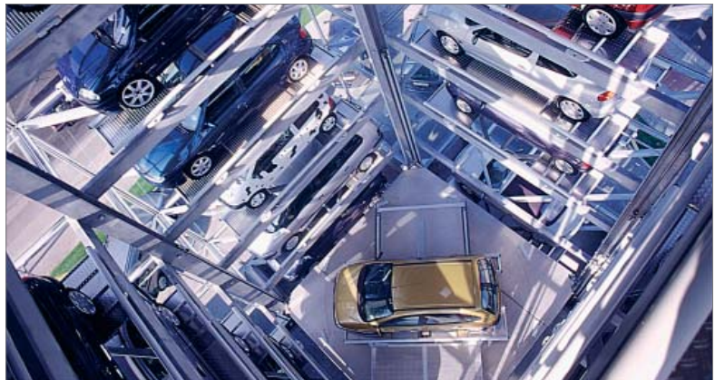
Rotation der Palette mit Fahrzeug um bis zu 180 Grad
