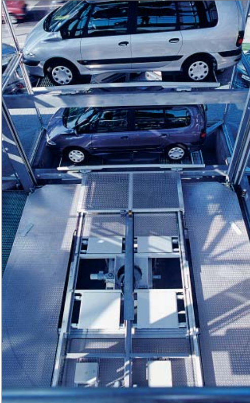
Shuttle-Lift lagert Fahrzeug mit Palette in das Fach ein
